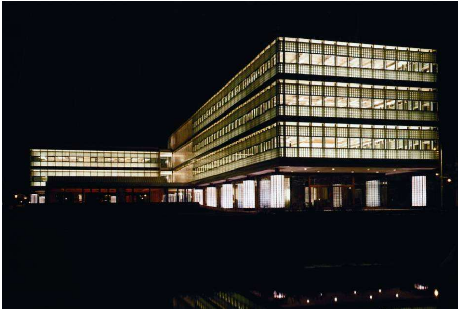
Besonders bei Nacht erstrahlt die Glassteinfassade des Gebäudes dank der Lichtführung der SOLARIS Glassteine
